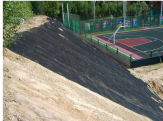
Рисунок 6 – Укріплення насипів дорожньою сіткою ПСБ-Д
