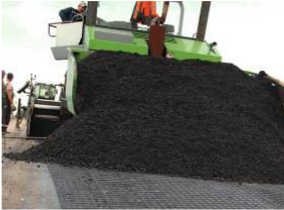
Рисунок 5 – Застосування дорожньої сітки ПСБ-Д при будівництві доріг
